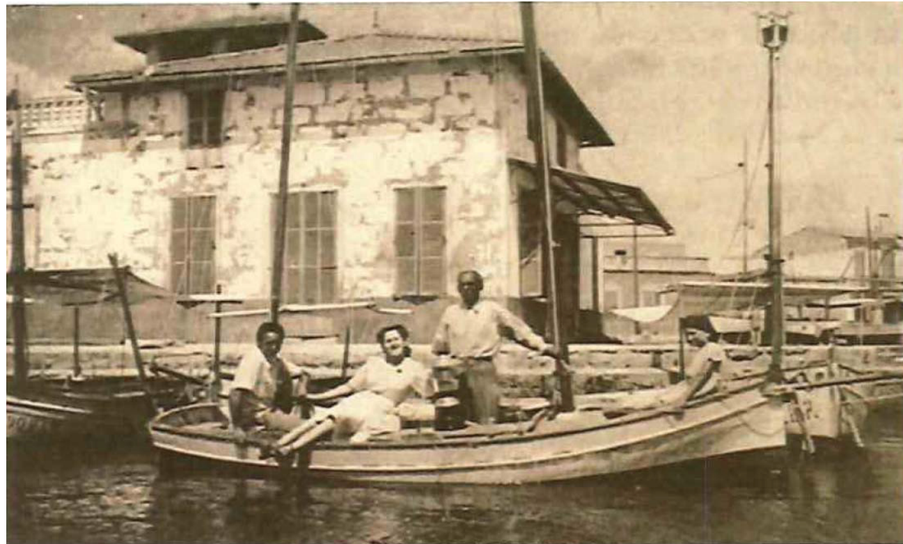
Figura 4. Foto histórica de la fachada Sur.
