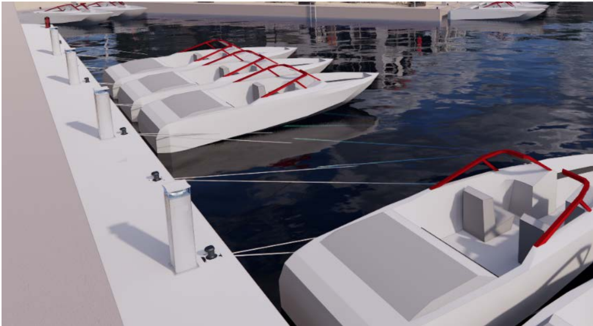
Figura 4.-Bolardos en cantil de muelle
