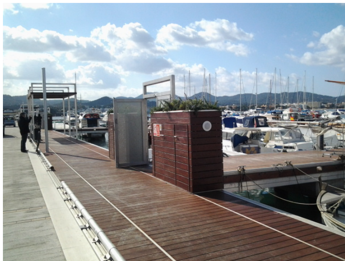
2 Sistema de ocultación de basuras
