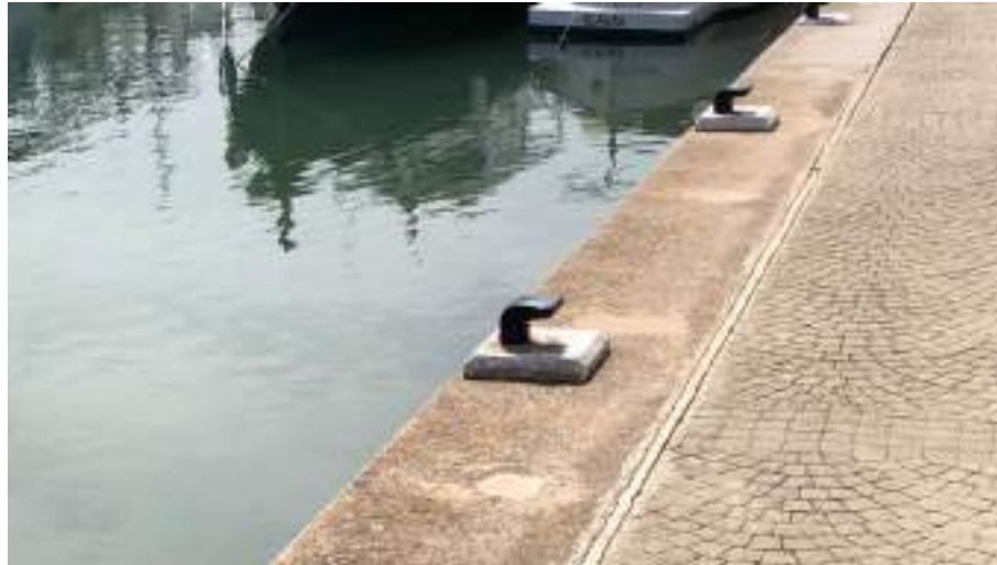
Figura 2.- Micropilotes ejecutados en muelle.
