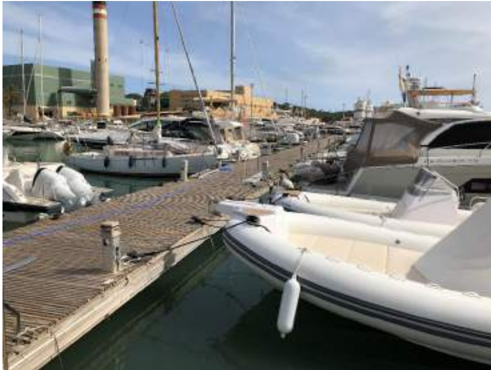
Figura 12.- Vista general de uno de los pantalanes.
