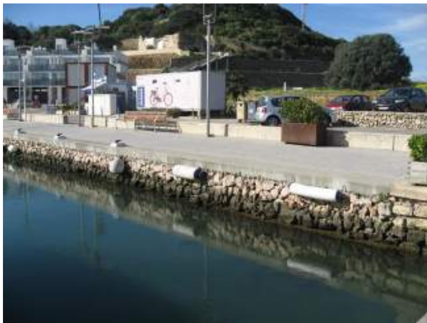
Figura 10.- Vista del muelle de ribera desde uno de los pantalanes.
