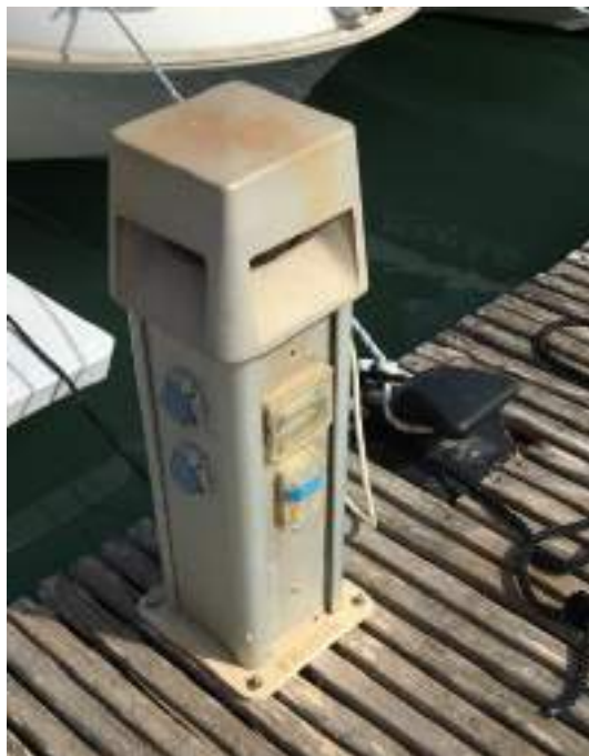
Figura 27.- Detalle de una de las torretas existentes.
