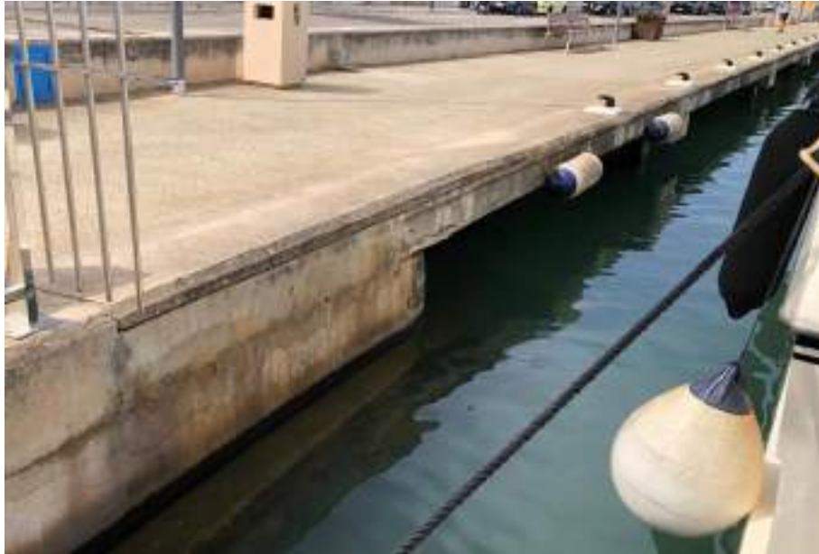
Figura 6.-Muelle pilotado en la zona de la Colàrsega.
