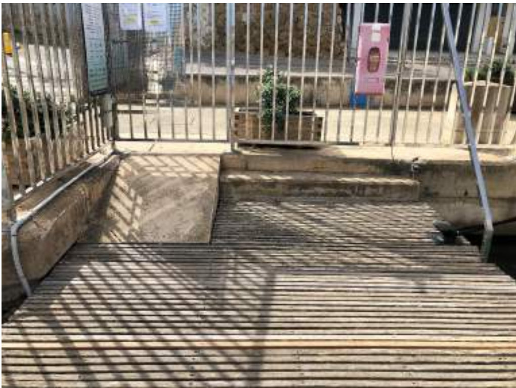
Figura 31.- Detalle de la rampa de acceso al pantalán 7.
