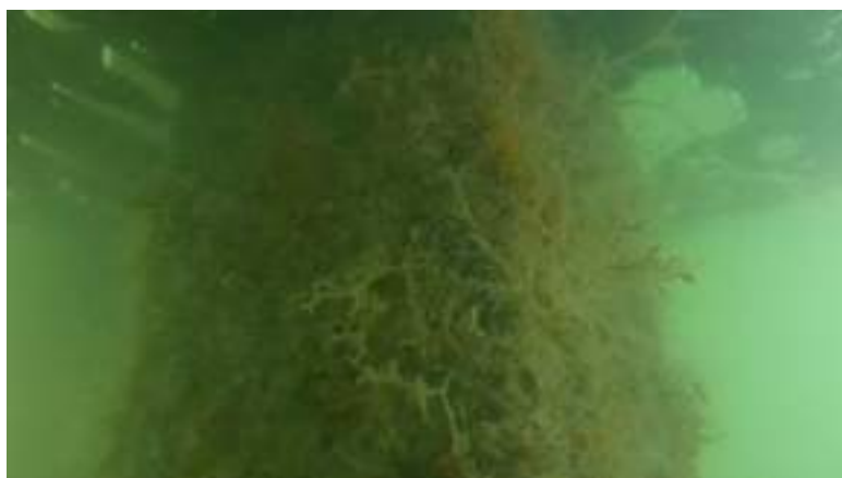
Detalle de uno de los pilotes del pantalán 2.
