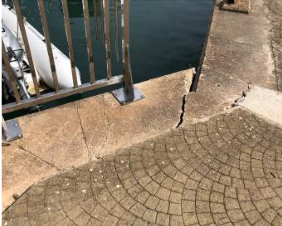
Figura 3.- Esquina de muelle a la altura del actual pantalán 7.
