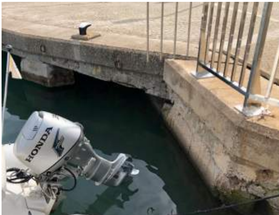
Figura 4.- Vista del muelle desde el actual pantalán 7.
