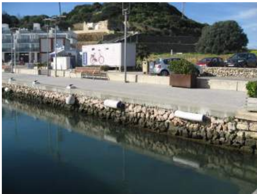
Figura 5.- Vista del muelle de ribera desde uno de los pantalanes.
