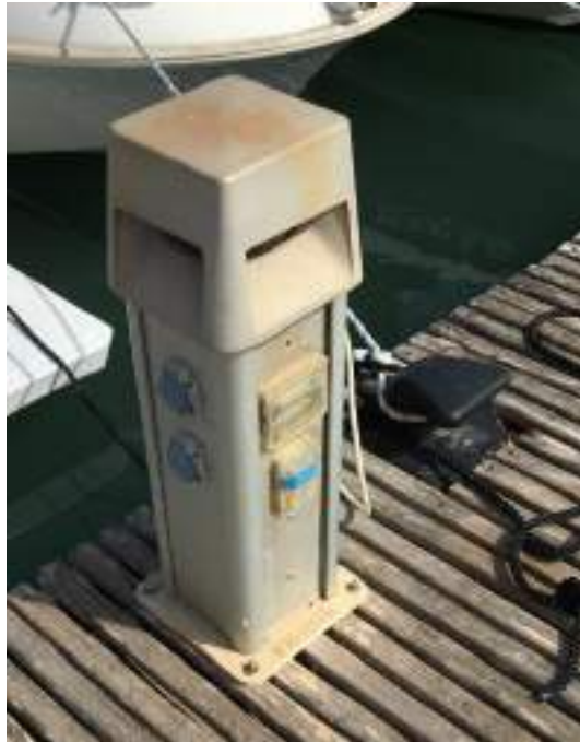
Figura 16.- Detalle de una de las torretas existentes.
