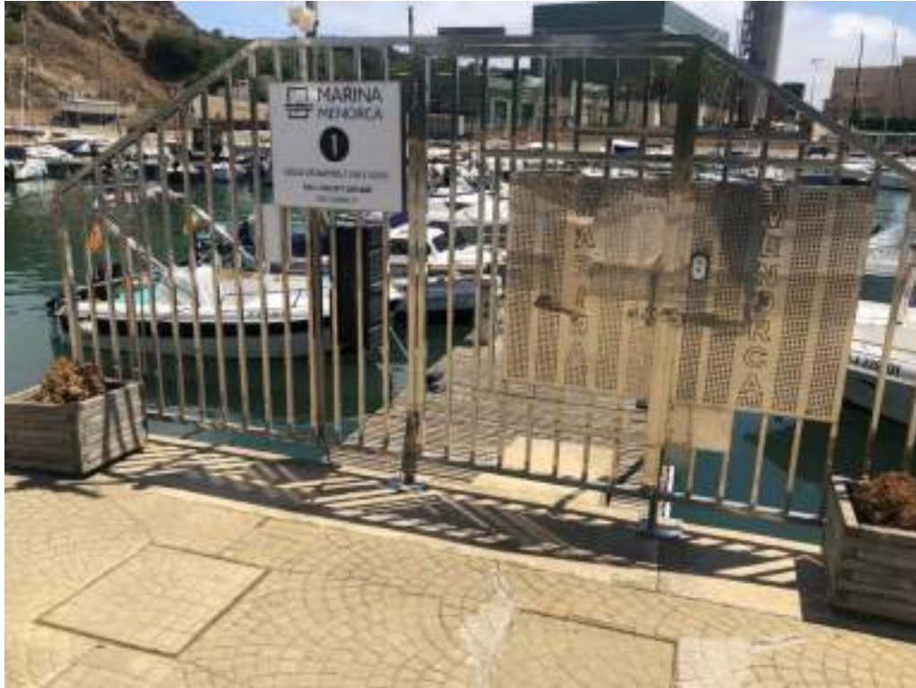
Figura 16.- Detalle del acceso al pantalán 1.
