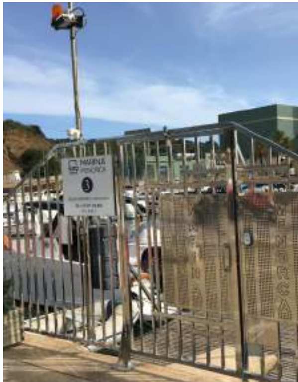
Figura 31.- Poste con luz de emergencia junto a acceso a pantalán.
