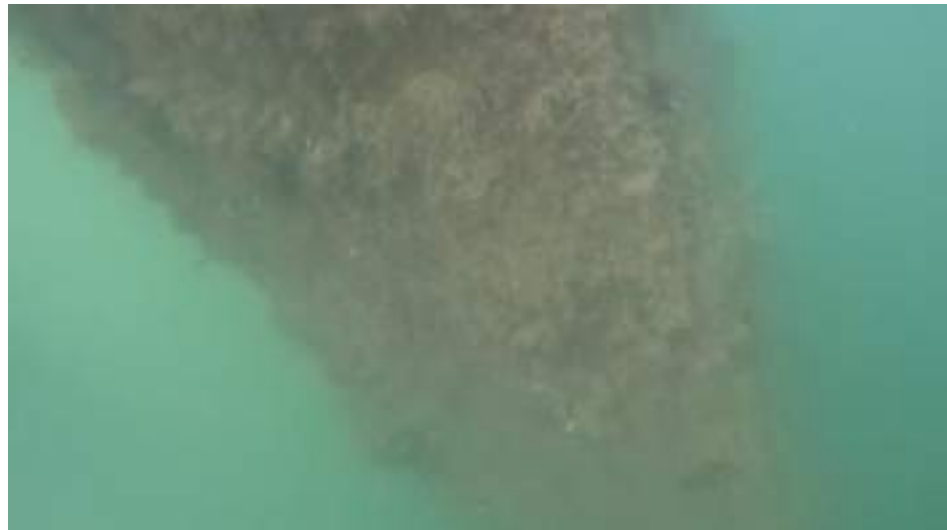
Detalle de uno de los pilotes del pantalán 1.
