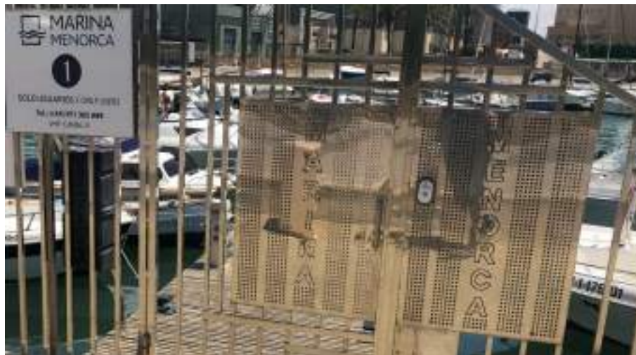
Figura 17.- Detalle del control de acceso al pantalán 1 mediante lector de tarjetas.
