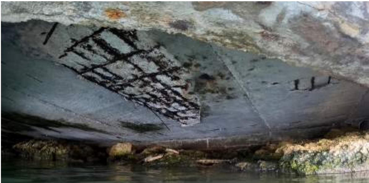
Figura 5.- Detalle parte inferior placa a la altura del actual pantalán 7.
