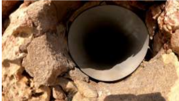
Figura 33.- Punto de vertido entre rampa varadero y pantalán 1.
