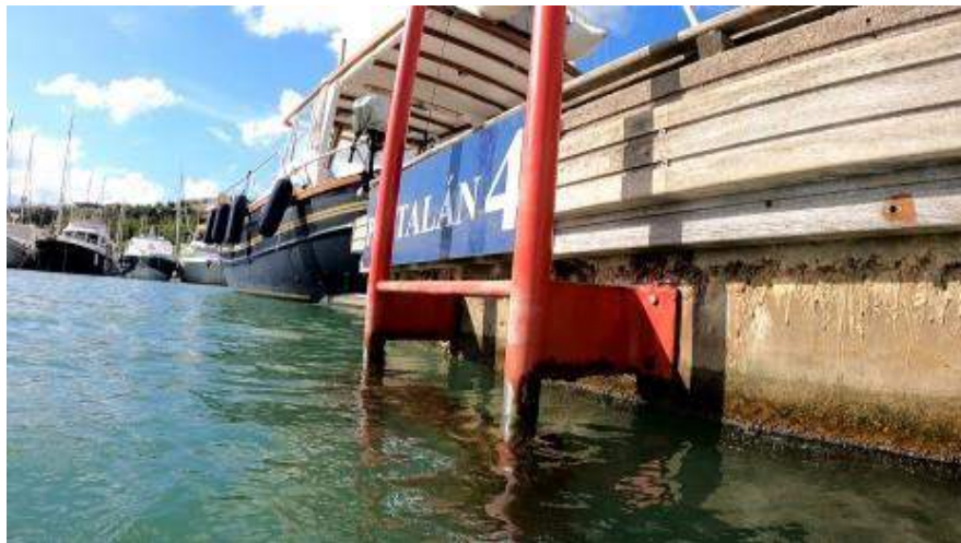
Detalle de la escalera adosada al pantalán 4.
