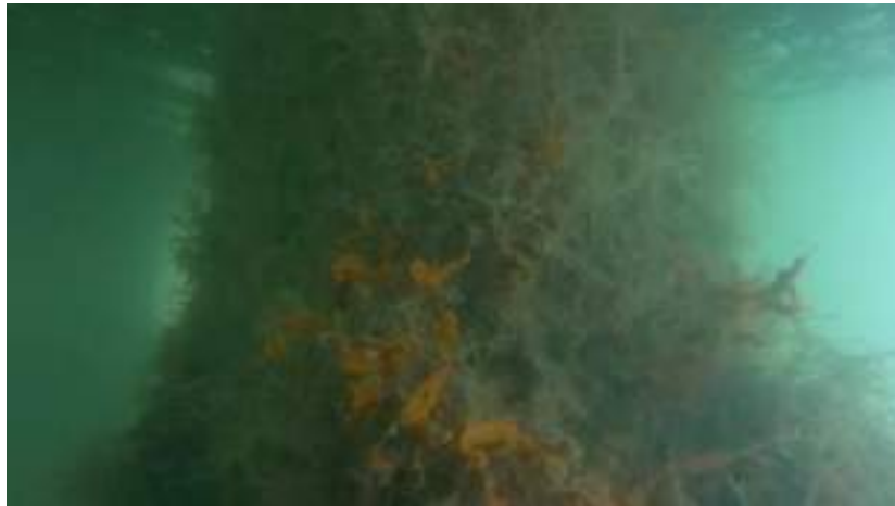
Detalle de uno de los pilotes del pantalán 3.
