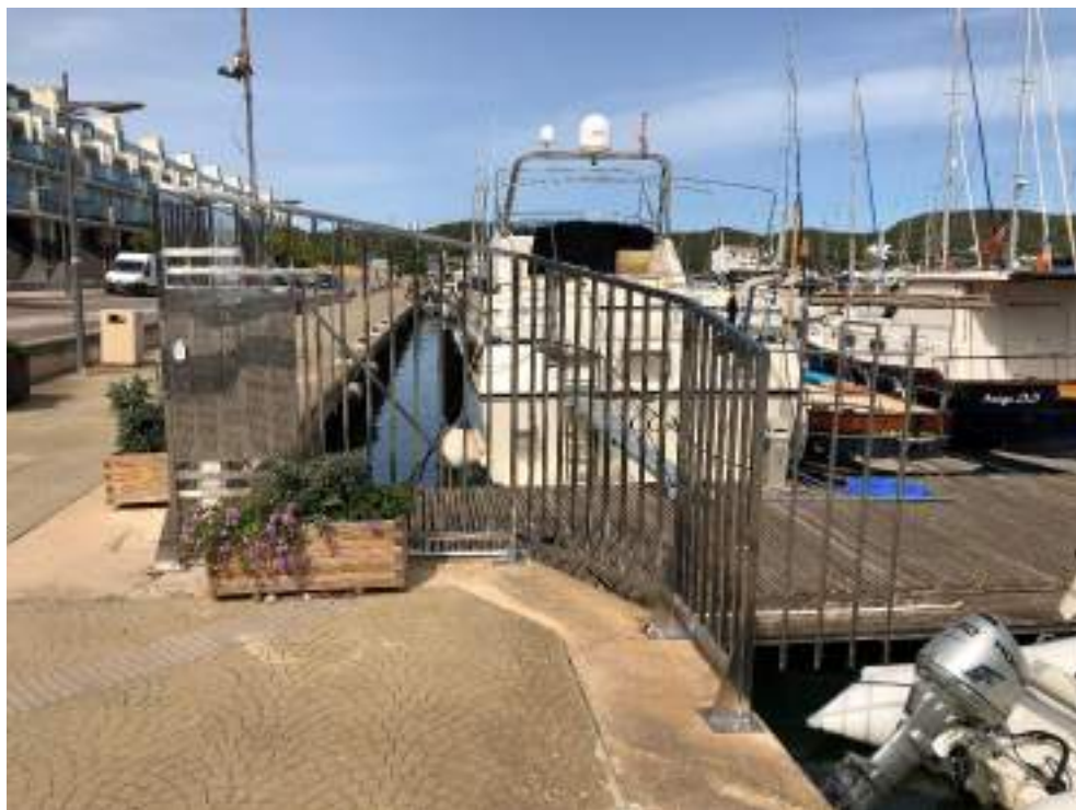
Figura 4.- Vista del tramo de muelle junto al acceso al pantalán 7.
