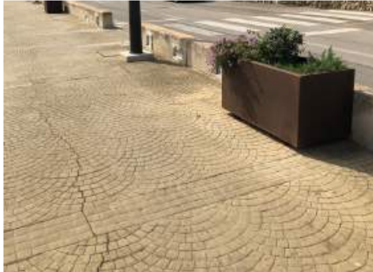
Figura 1.- Pavimento en el tramo de muelle macizo.
