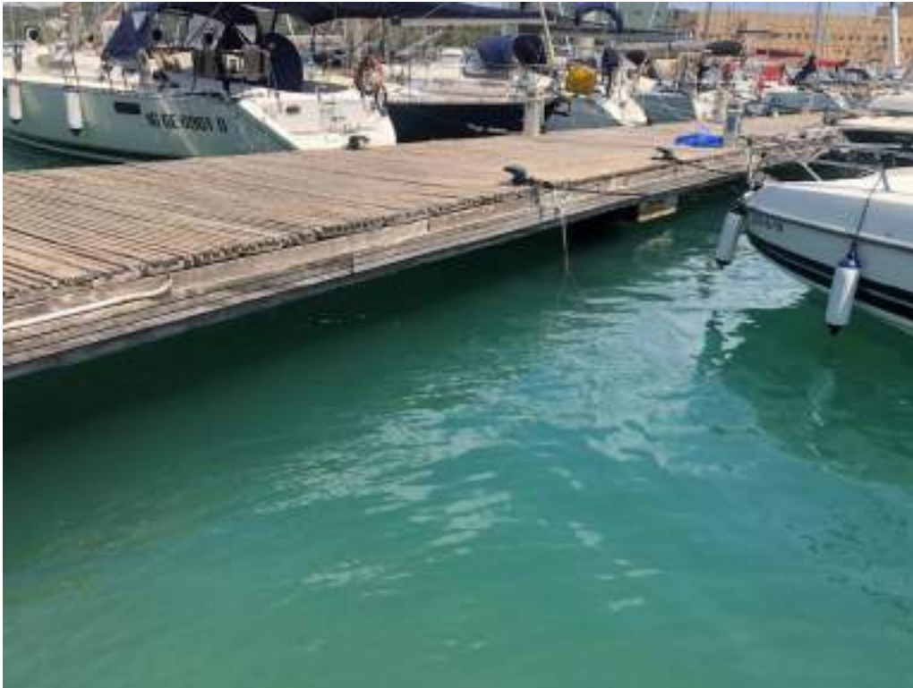
Figura 30.- Vista del pantalán 7 (II)
