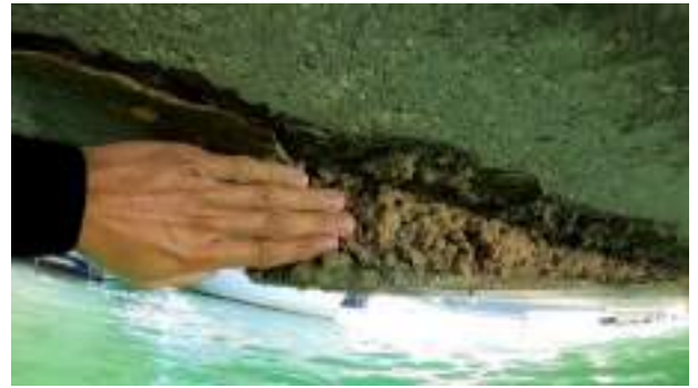
Patología en una de las losas de hormigón del pantalán 4
