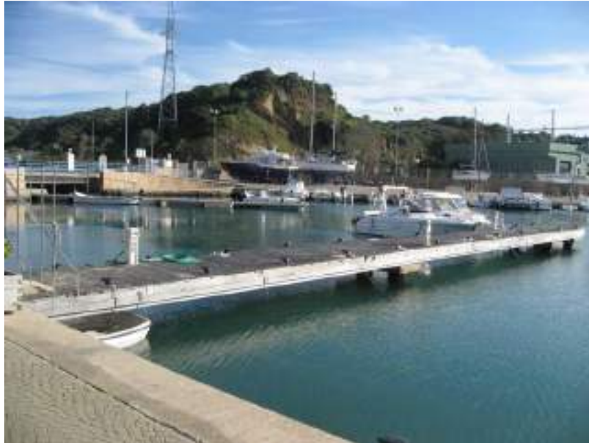
Figura 4.- Vista general de uno de los pantalanes.
