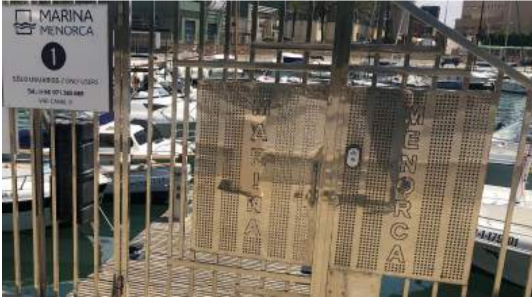
Figura 30.- Detalle del control de acceso al pantalán 1 mediante lector de tarjetas.
