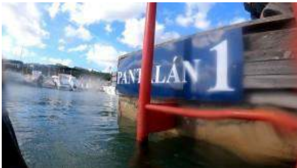
Detalle de la escalera adosada al pantalán 1.
