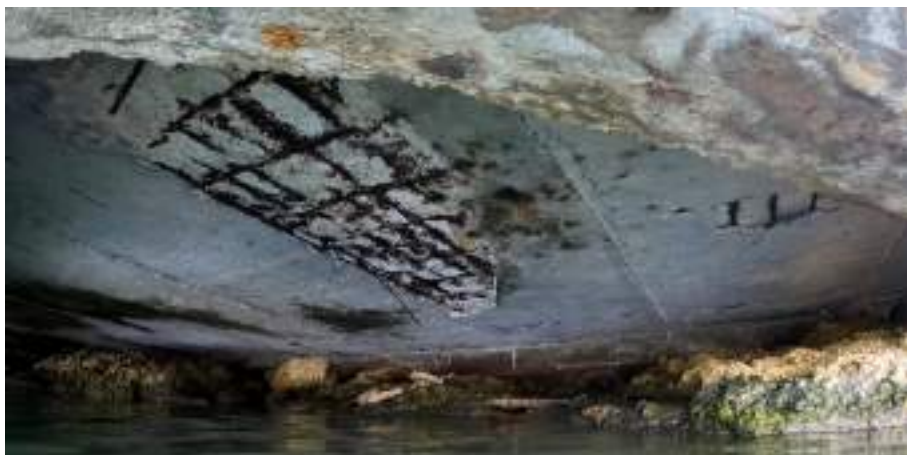
Figura 25.- Detalle parte inferior placa a la altura del actual pantalán 7.
