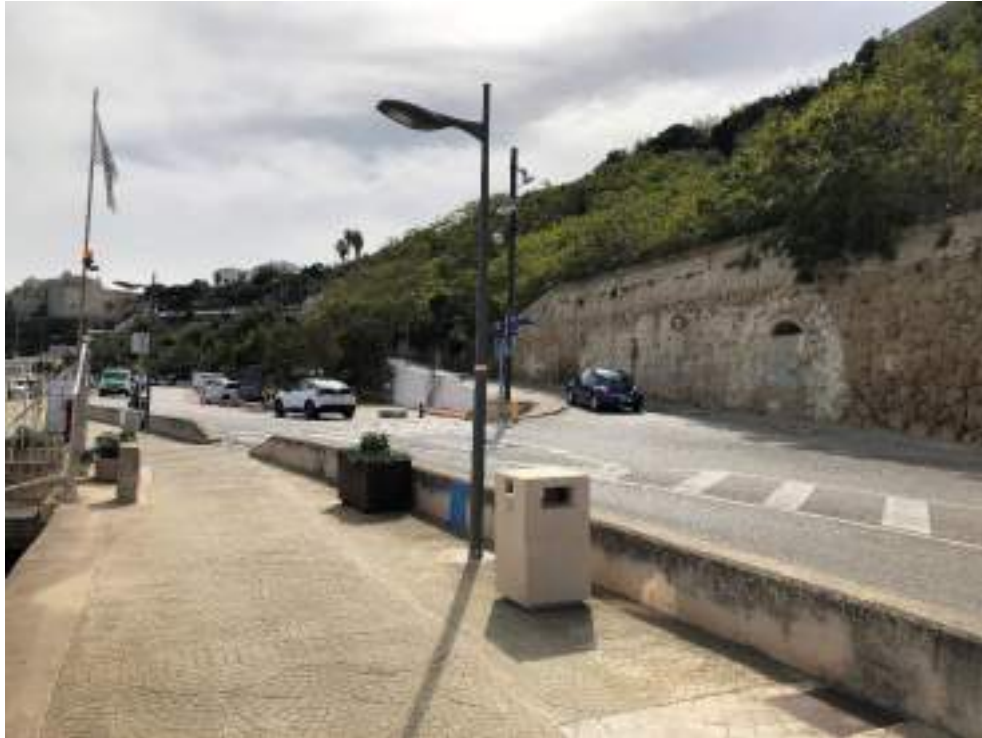
Figura 1.- Vista del paseo peatonal del muelle de la Colàrsega, en su tramo frente al pantalán 7
