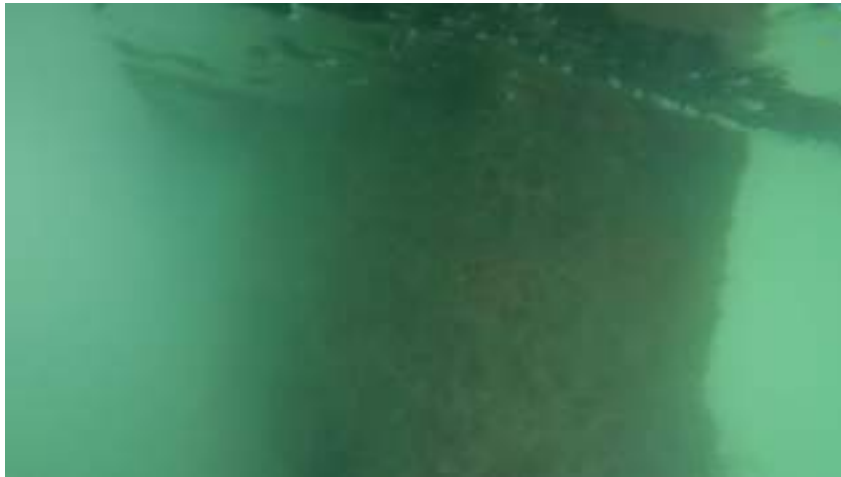
Detalle de uno de los pilotes del pantalán 4.
