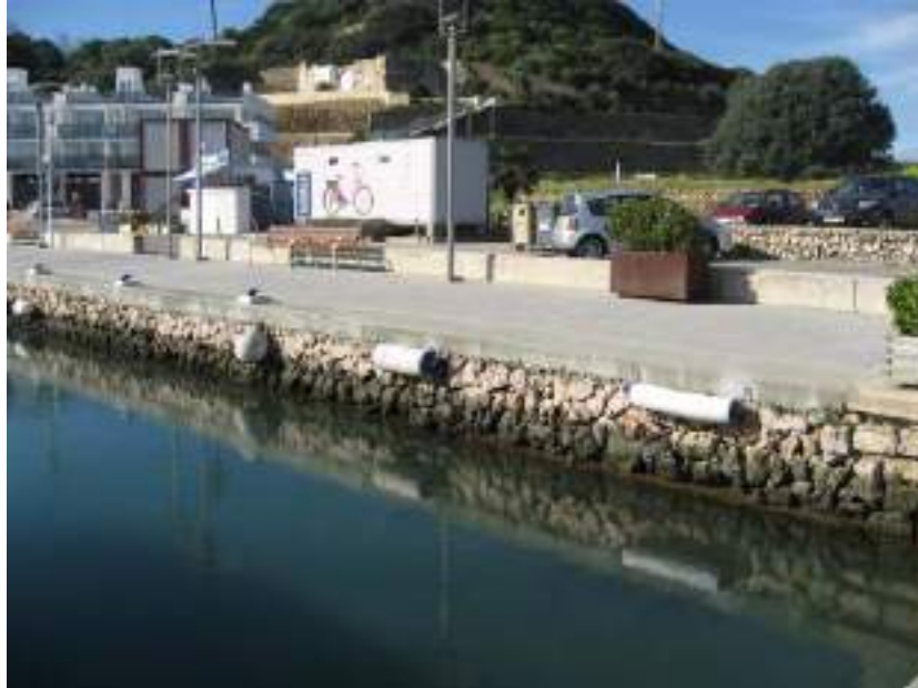
Figura 2.- Muelle de gravedad en la zona de la Colársega.
