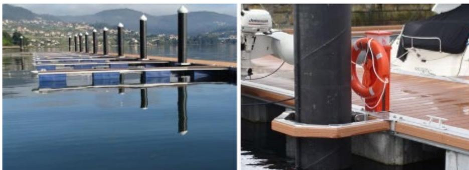
Figura 16. Pilotes guía metálicos para pantalanes flotantes (Fuente: AMILIBIA)
