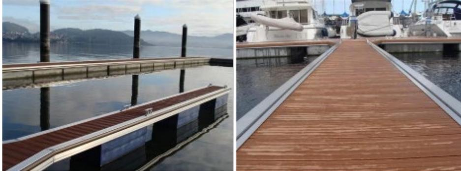
Figura 14. Material ECO-DECK en pantalanes flotantes (Fuente: AMILIBIA)
