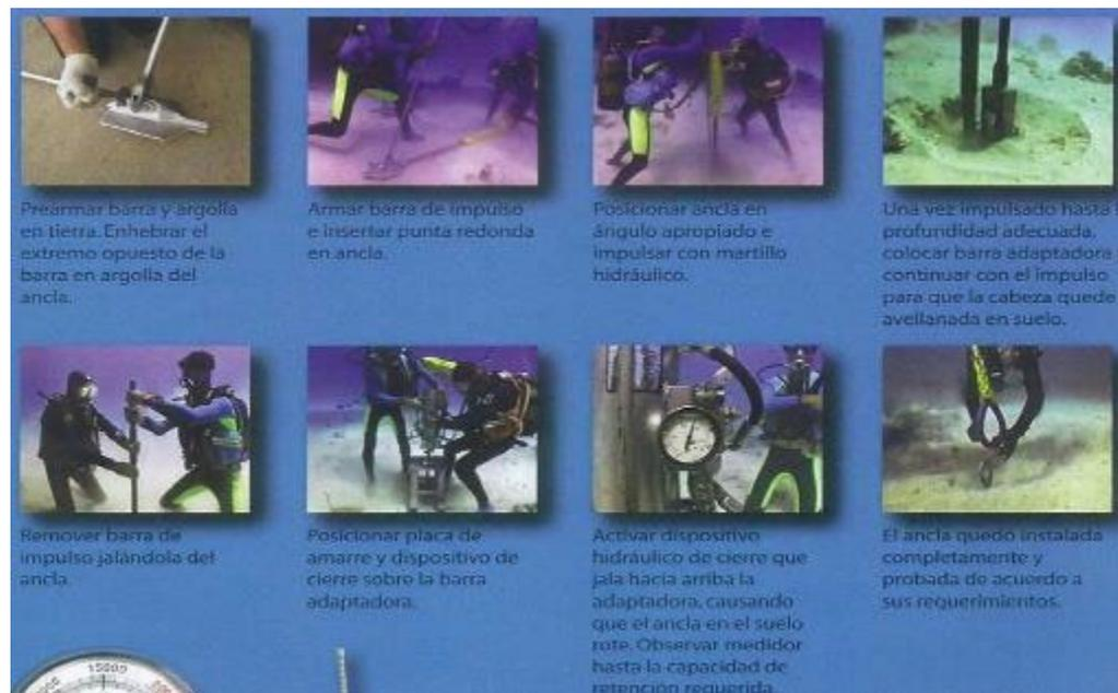
Figura 15. Instalación de anclajes MANTA-RAY bajo el agua (Fuente: MANTA-RAY)
