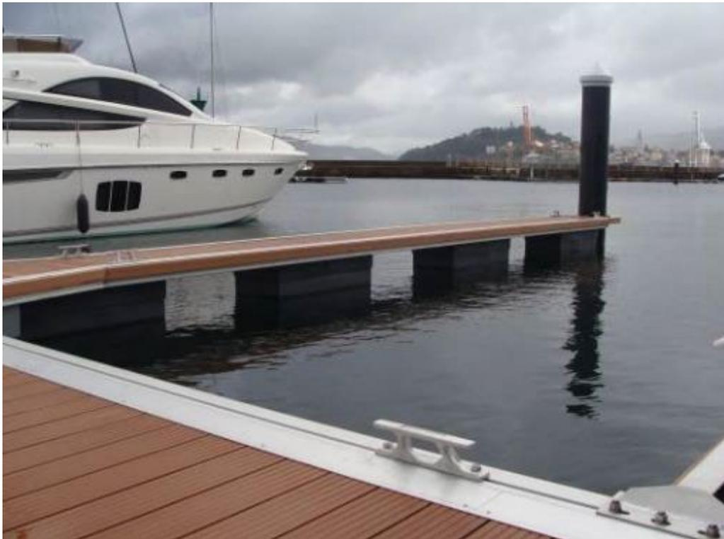
Figura 20. Finger flotante con pilote guía (Fuente: AMILIBIA)
