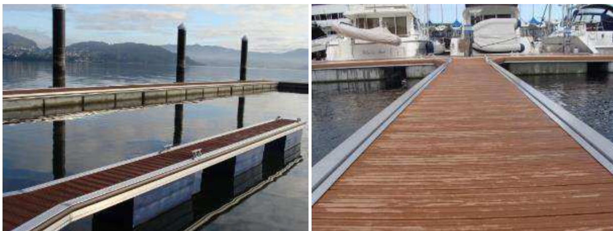
Figura 7. Material ECO-DECK en pantalanes flotantes (Fuente: AMILIBIA)
