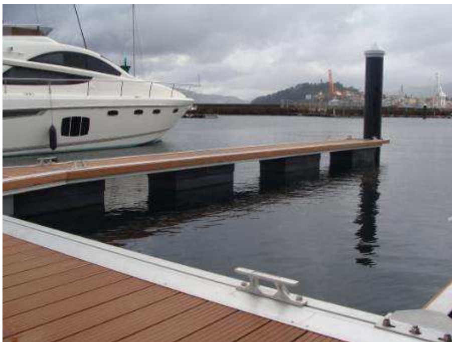
Figura 14. Finger flotante con pilote guía (Fuente: AMILIBIA)
