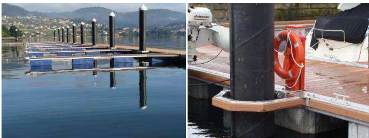
Figura 10. Pilotes guía metálicos para pantalanés flotantes (Fuente: AMILIBIA)
