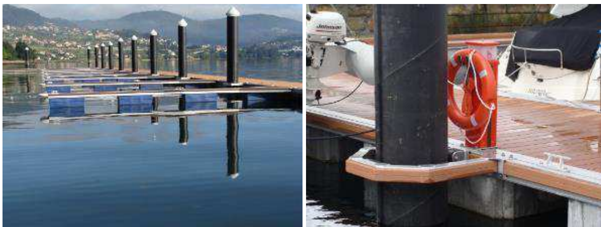
Figura 5. Pilotes guía metálicos para pantalanés flotantes (Fuente: AMILIBIA)
