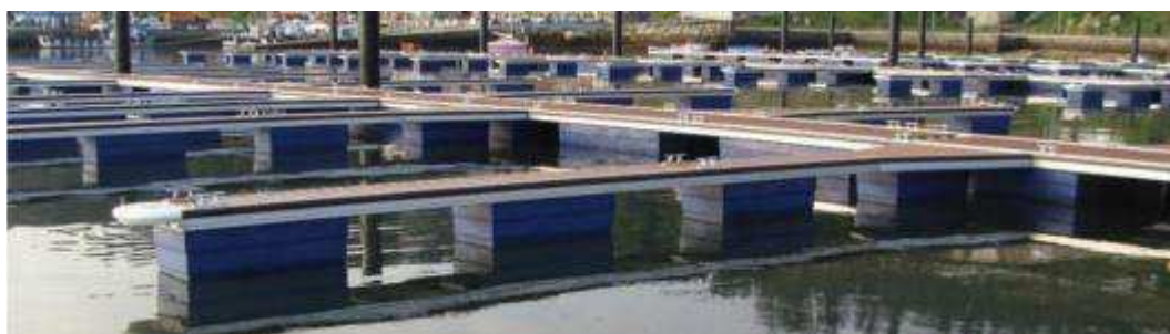
Figura 12. Finger flotante (Fuente: AMILIBIA)
