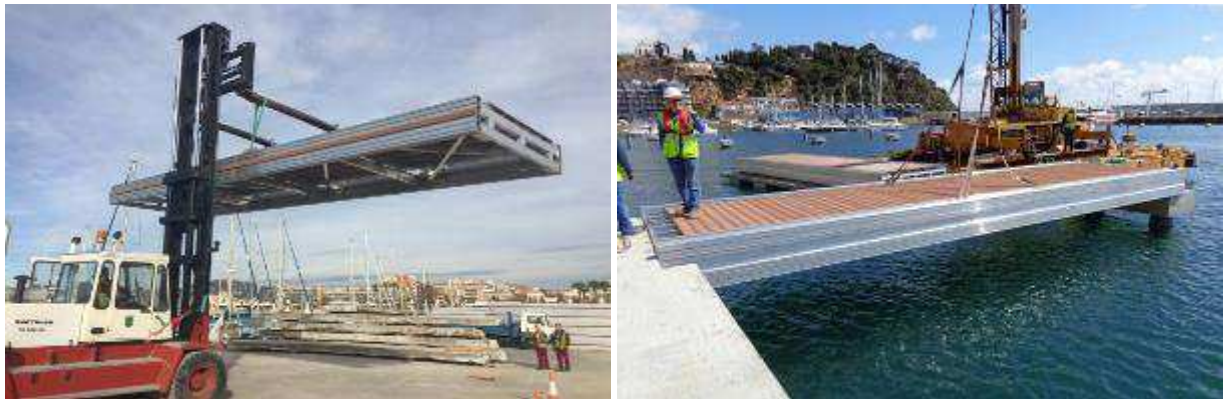
Figura 20. Superestructura para pantalanes fijos (Fuente: AMILIBIA)
