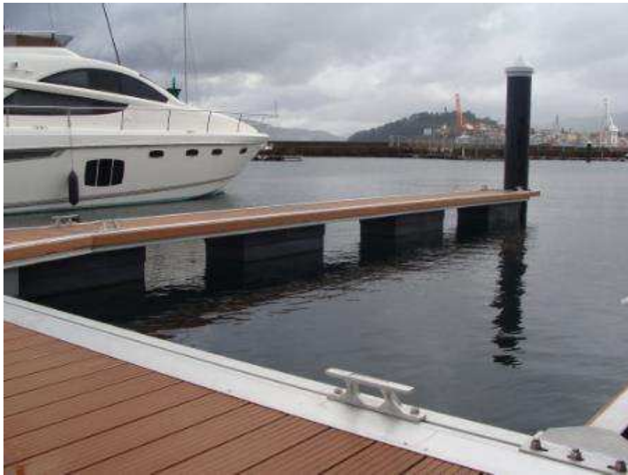
Figura 23. Finger flotante con pilote guía (Fuente: AMILIBIA)
