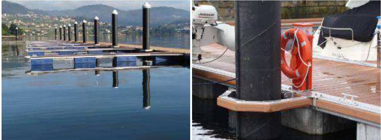
Figura 19. Pilotes guía metálicos para pantalanes flotantes (Fuente: AMILIBIA)
