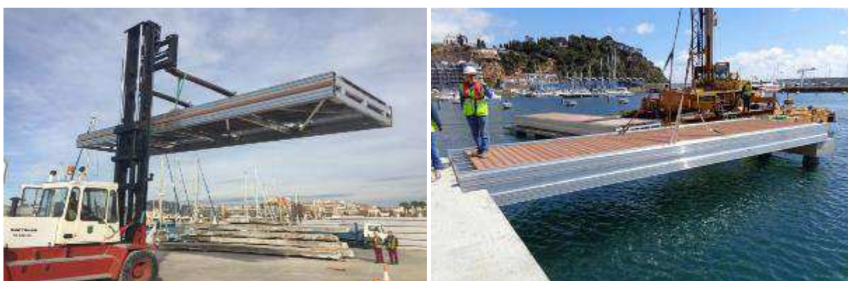
Figura 11. Superestructura para pantalanés fijos (Fuente: AMILIBIA)
