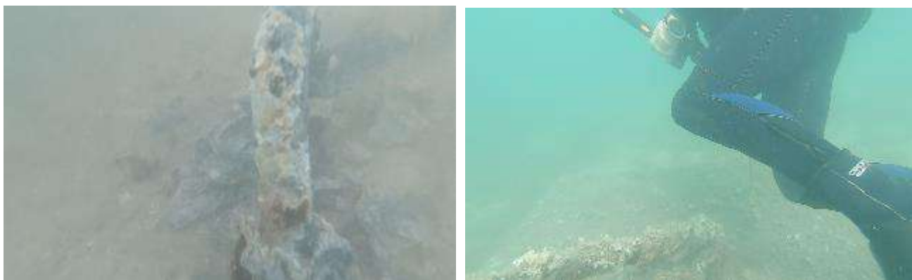
Figura 10. Inspección subacuática en Cala Llonga
