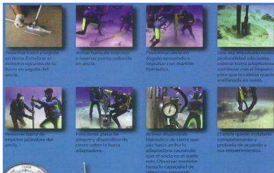
Figura 18. Instalación de anclajes MANTA-RAY bajo el agua (Fuente: MANTA-RAY)
