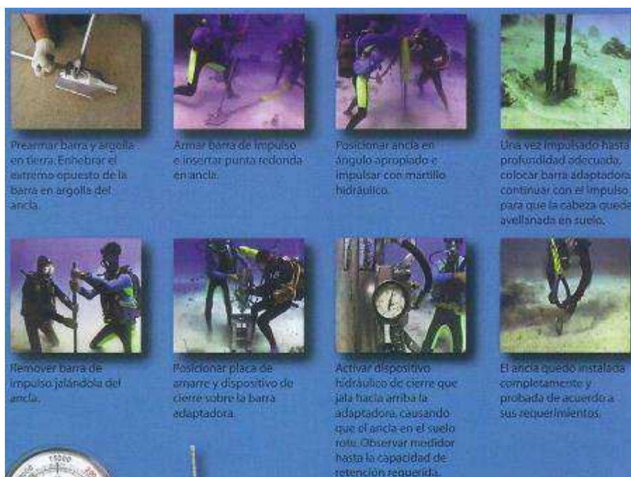
Figura 9. Instalación de anclajes MANTA-RAY bajo el agua (Fuente: MANTA-RAY)
