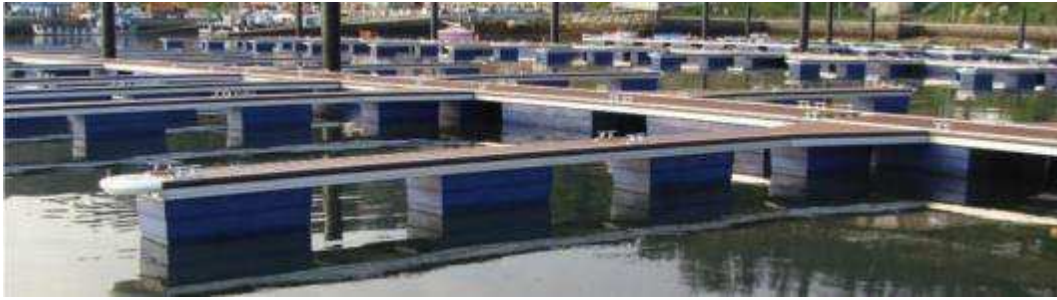
Figura 21. Finger flotante (Fuente: AMILIBIA)
