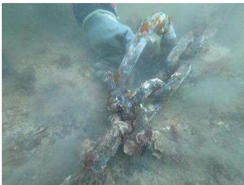
Figura 66. Unión con muerto de fondeo en Isla del Rey
