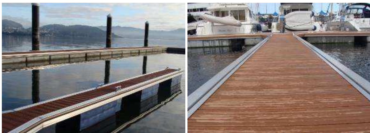
Figura 6. Material ECO-DECK en pantalanés flotantes (Fuente: AMILIBIA)
