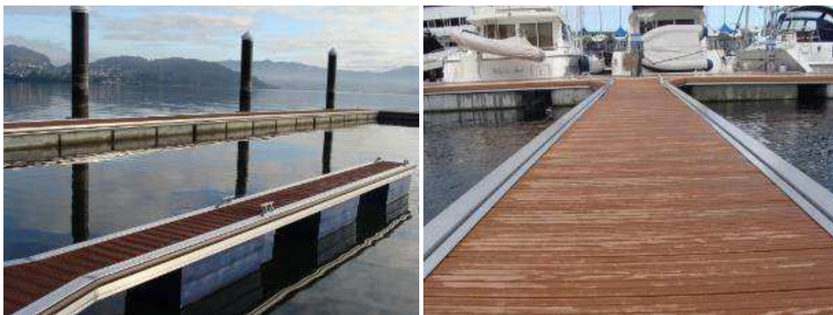
Figura 16. Material ECO-DECK en pantalanés flotantes (Fuente: AMILIBIA)
