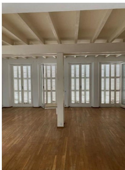
Figura 9.- Interior del edificio 7.
