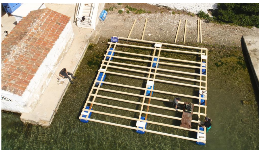
Figura 3.- Ejemplo de construcción de una batea para cultivo de mejillones.
