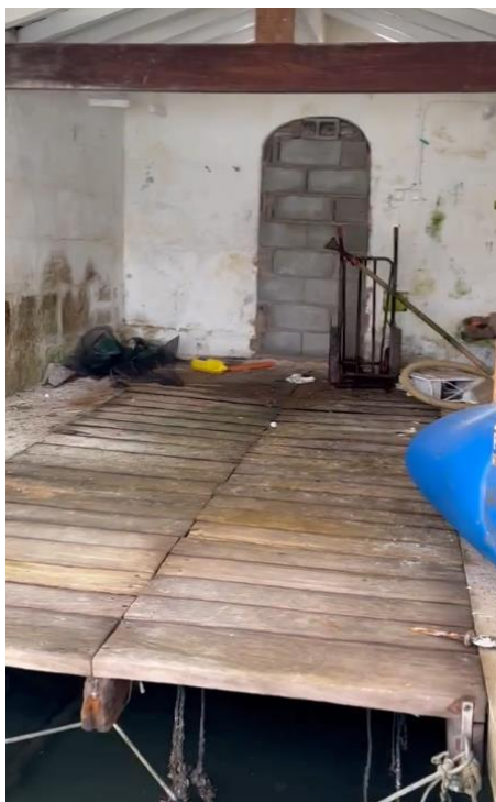
Figura 7.- Interior de la edificación 11 en parcela 10.
