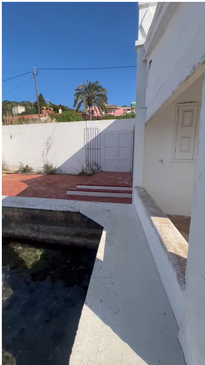
Figura 17.- Zona de paso exterior entre edificio 6 y 7.
