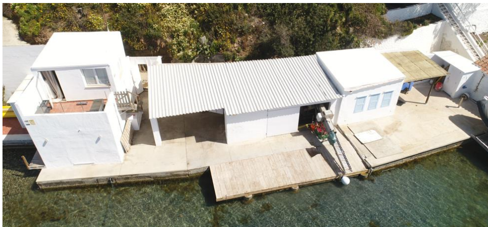
Figura 14.- Edificios y estructuras a demoler.
