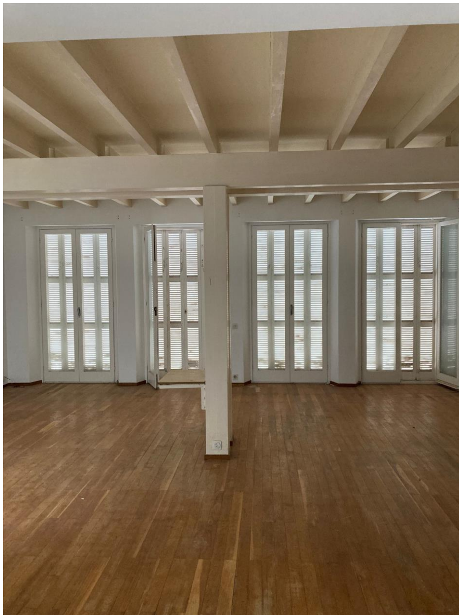
Figura 21.- Interior del edificio 7.
