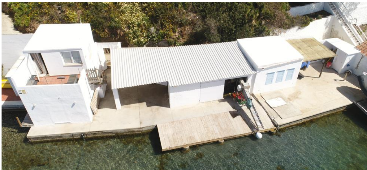
Figura 1.- Edificios y estructuras a demoler.
