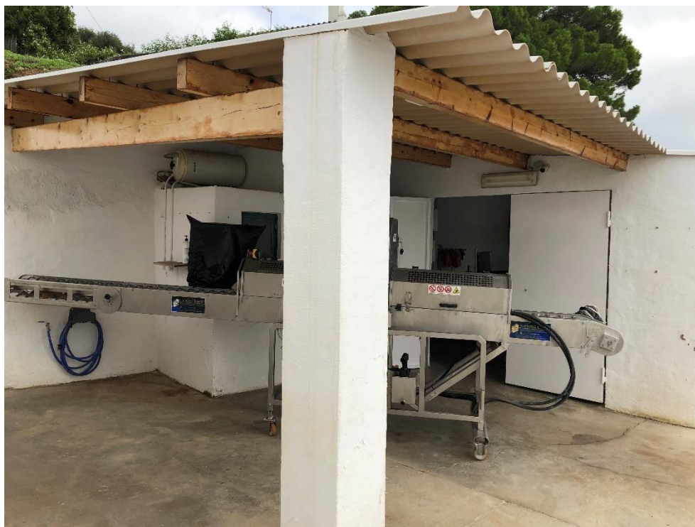
Figura 12.- Zona de maquinaria bajo techo existente.
