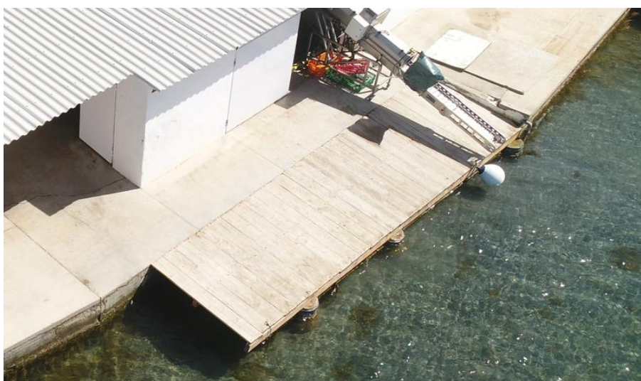
Figura 1.- Rampa de madera existente anclada al muelle.
