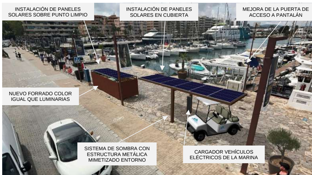
Figura 4. Instalación de nuevo sistema de sombra
