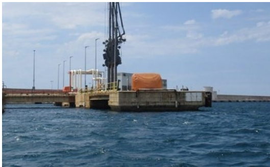
Figura 3. Vista general de la plataforma (lado norte) antes del incidente
