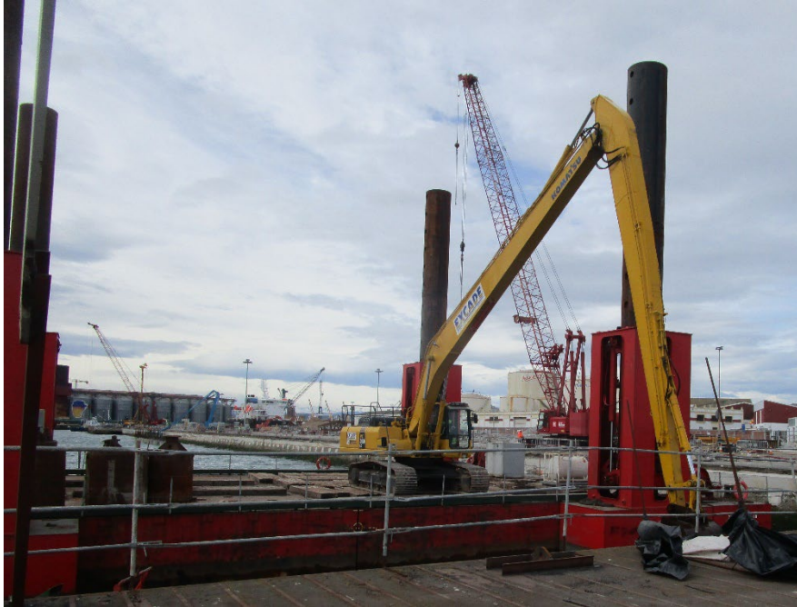
Figura 1. Retro de brazo largo sobre pontona.
