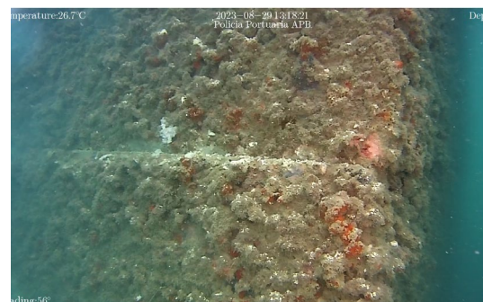
Figura 20. Junta entre bloques a cota -5.2m de pila P-5
