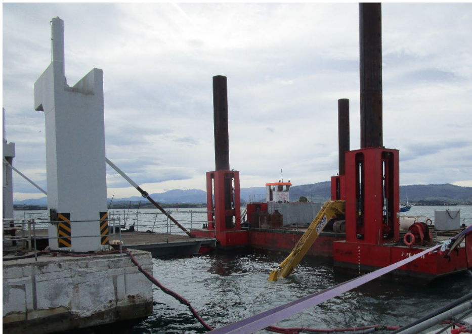
Figura 2. Retro de brazo largo sobre pontona en tareas de demolición submarina.
