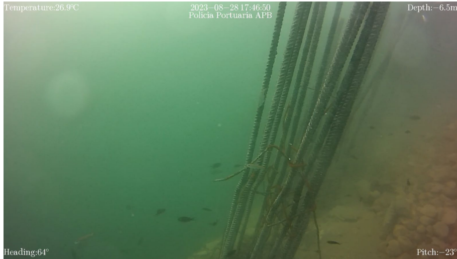
Figura 15. Pasadores o conexión entre bloques P-6 y relleno de grava
