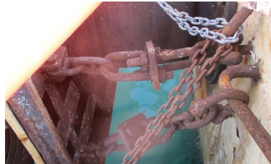
Figura 9. Estado de las cadenas de la defensa de P-5
