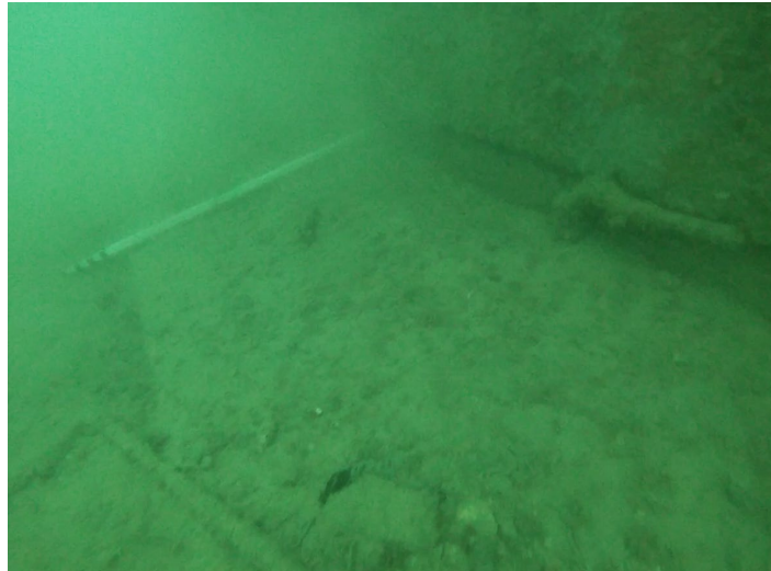
Figura 7. Inspección cimentación pila P2.
