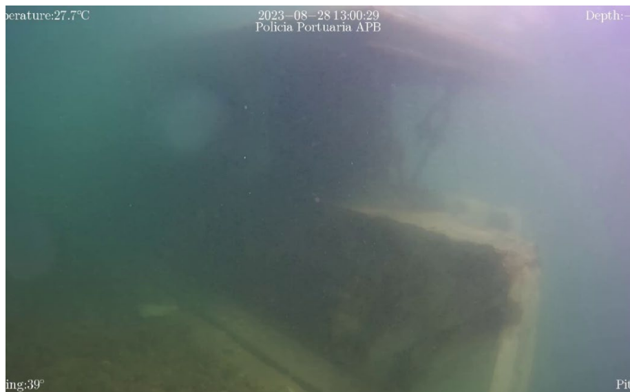
Figura 13. Captura de la posición de la defensa doble en pila P-6 tras hundirse
