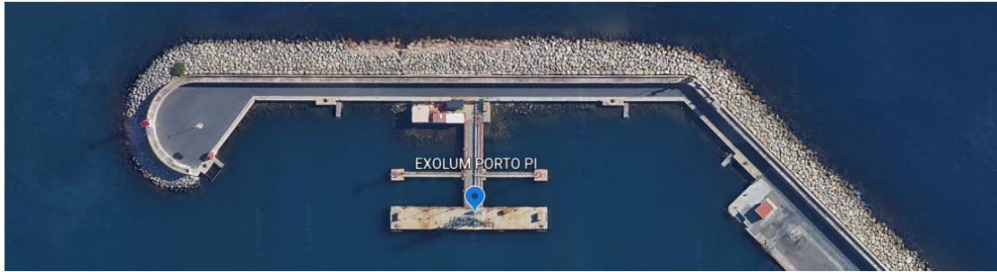
Figura 2. Vista aérea del Terminal de EXOLUM
