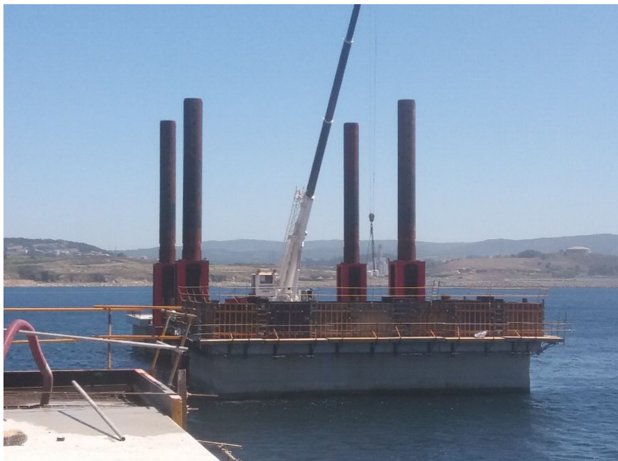
Figura 8. Ejecución de superestructura con medios marítimos.
