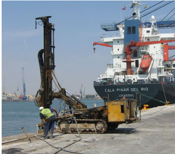
Figura 6. Perforación desde superestructura.
