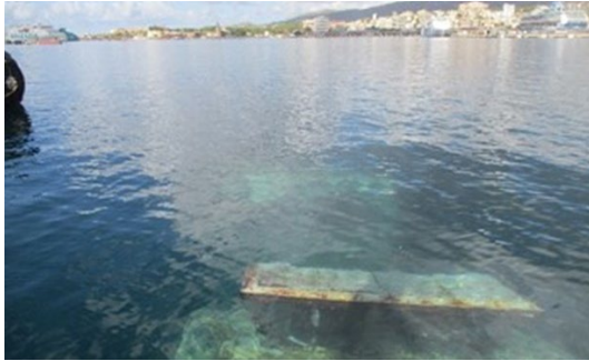
Figura 6. Defensa doble en P-6 hundida
