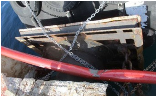
Figura 6. Defensa doble en P-6 hundida
