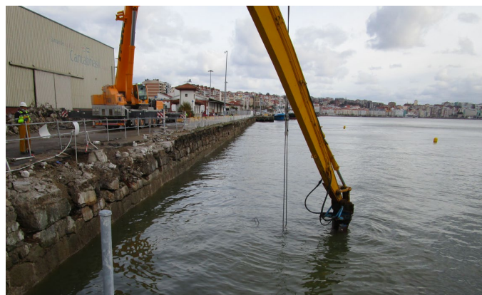
Figura 10. Demolición e izado de elementos sumergidos.
