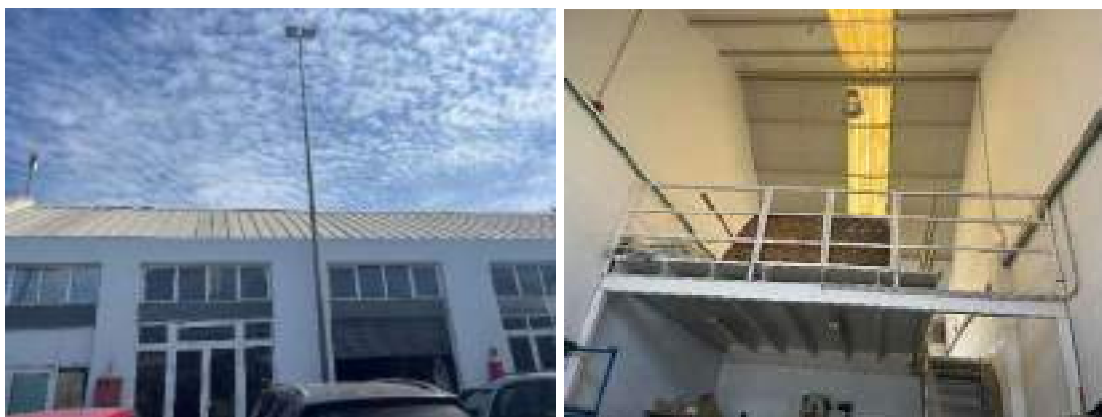
Figura 5. Diferentes vistas de la cubierta de la nave
