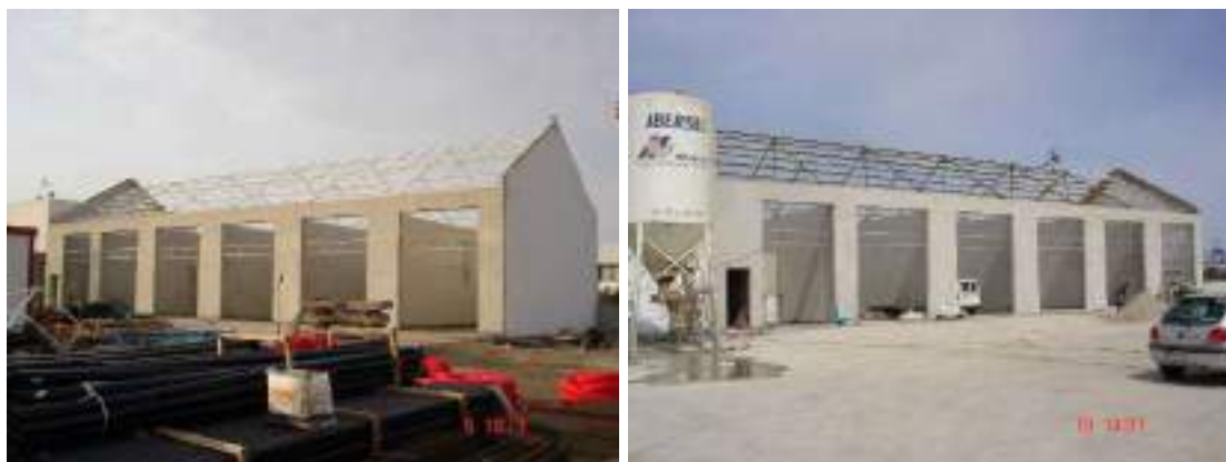
Figura 3. Momento de construcción de la nave industrial existente
