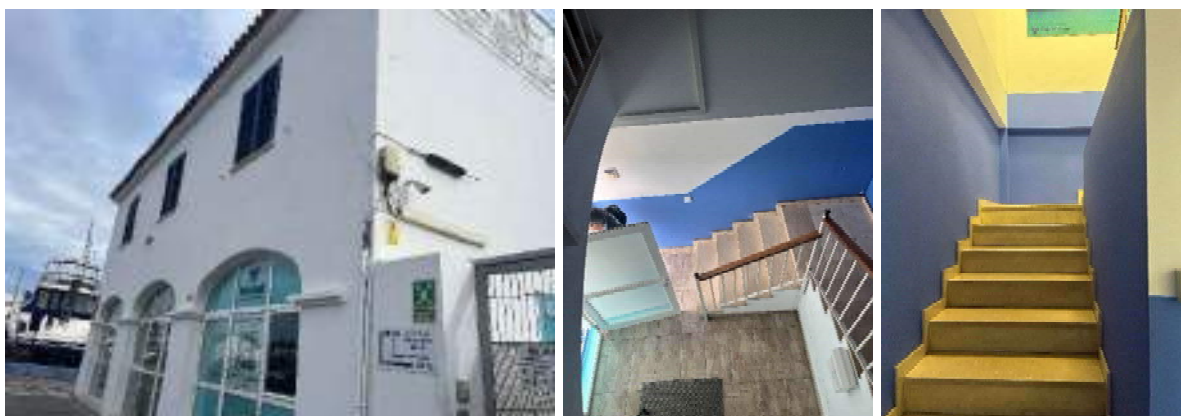
Figura 8. Fachada y escalera de acceso a la planta primera
