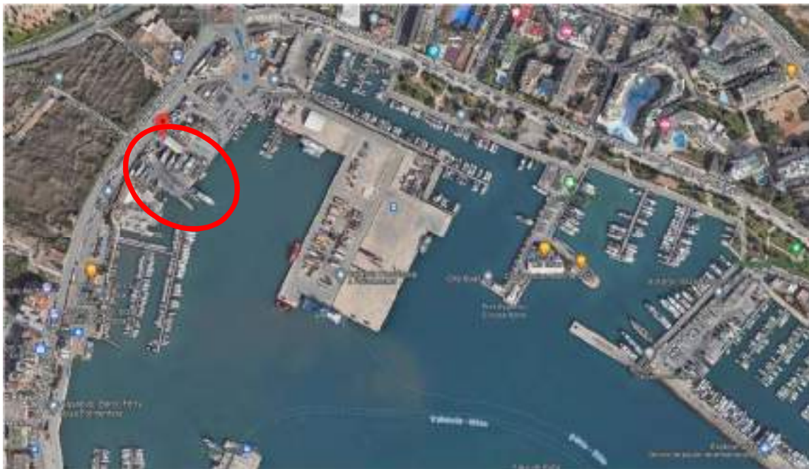
Vista aérea. Ubicación del varadero en el Puerto de Ibiza
