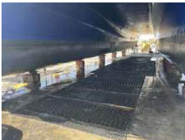
Figura 6. Foso en explanada para mantenimiento de embarcaciones de vela
