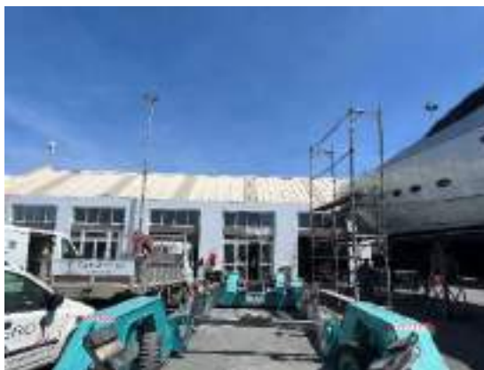
Figura 4. Puertas existentes en fachada suroeste
