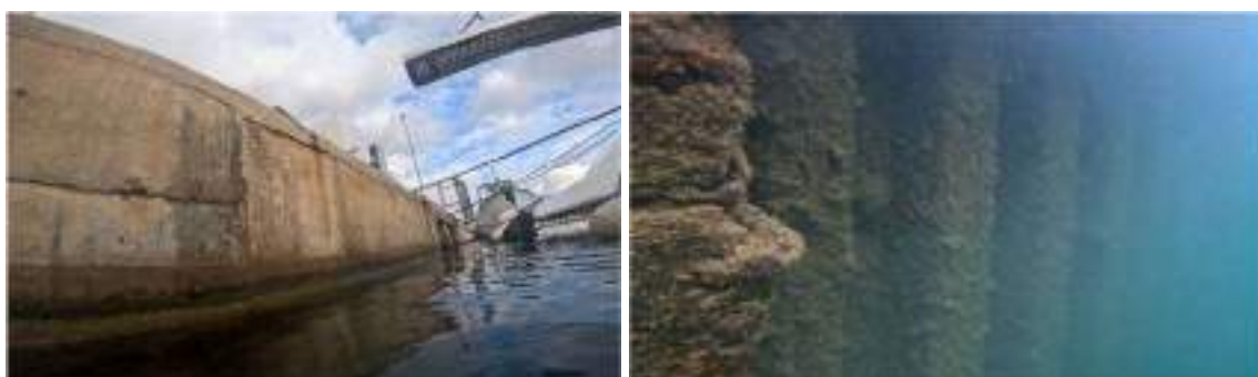
Figura 17. Muelle vertical de hormigón con tablestaca en su parte sumergida
