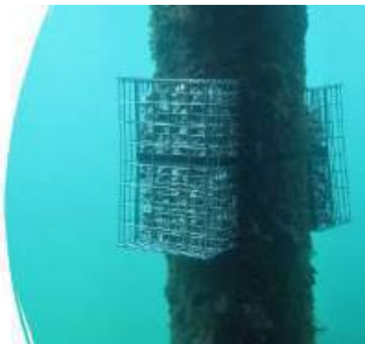
Figura 17. Biohut en pilotes
