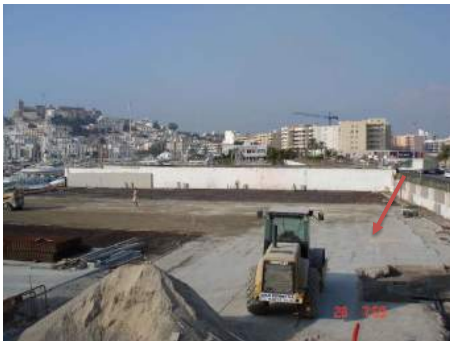
Figura 15. Canal de pluviales
