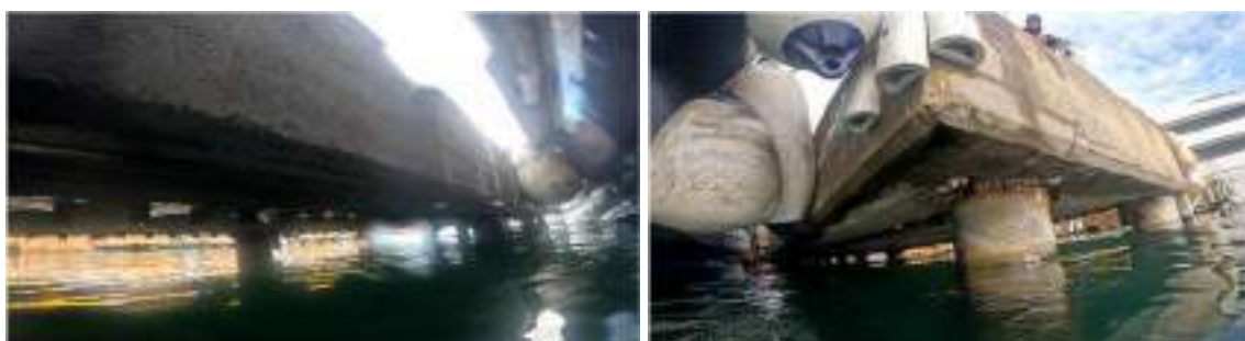
Figura 16. Muelles verticales de hormigón en zona grúa
