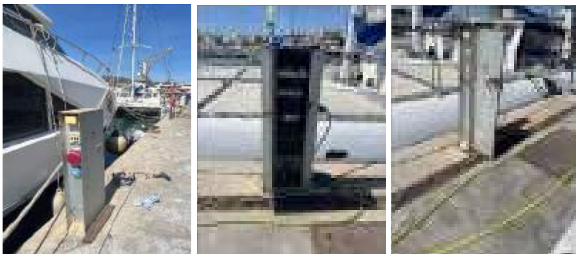
Figura 27. Estado actual de torretas de suministro junto al cantil
