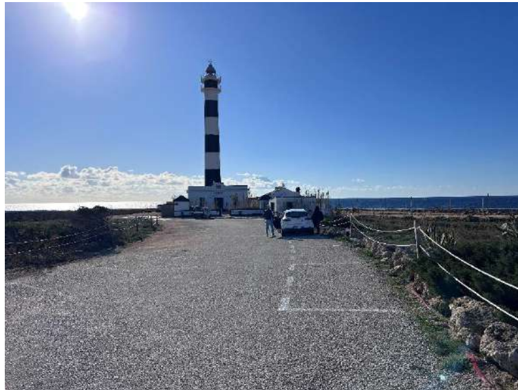
Figura 8. Vial de acceso al faro
