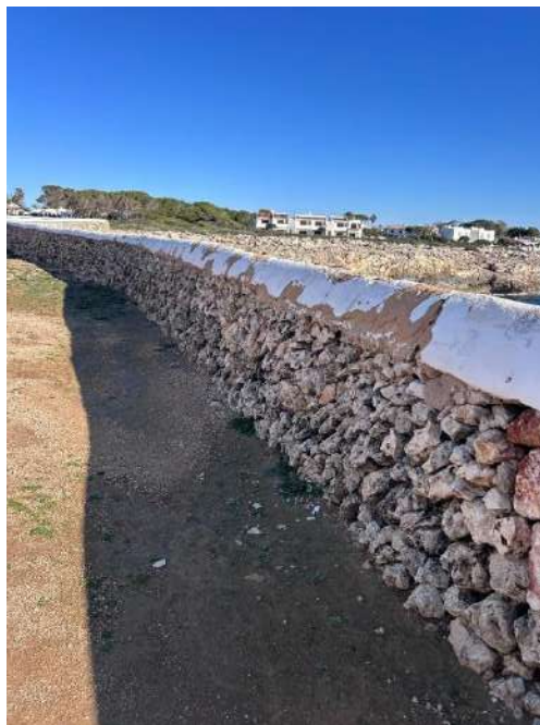
Figura 12. Muro de cierre de parcela
