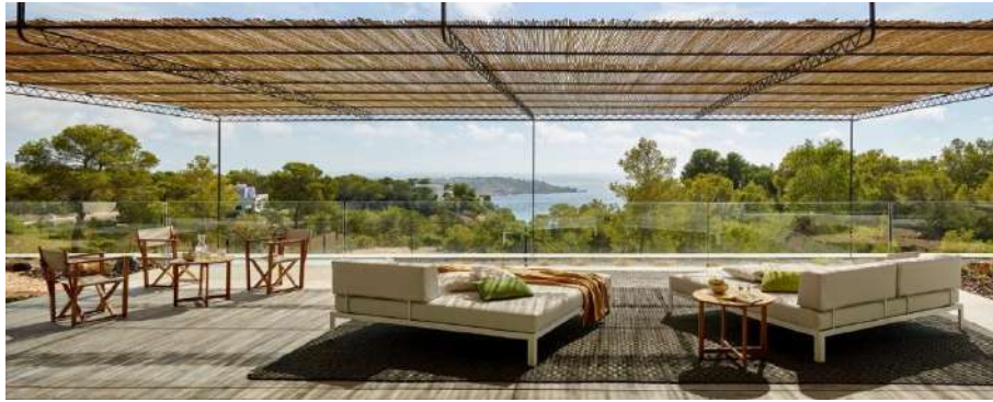
Figura 17. Ejemplo de cobertura de cañizo desmontables utilizados en las terrazas
