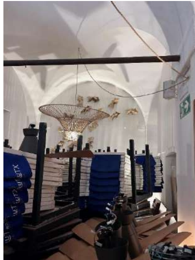
Figura 13. Bóvedas, interior del edificio del faro
