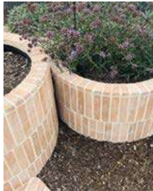
Figura 23. Ref jardineras de obra revestidas con elemento cerámico en combinación con la estética del proyecto
