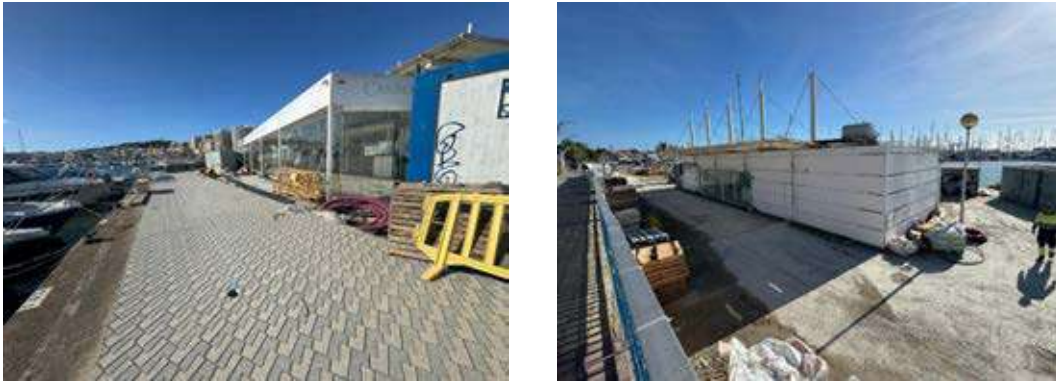
Figura 6. Imágenes del estado actual.
