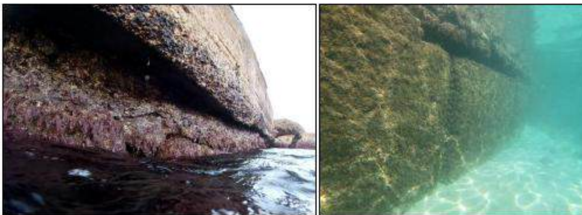
Ilustración 2: foto de la lavadura de junta
