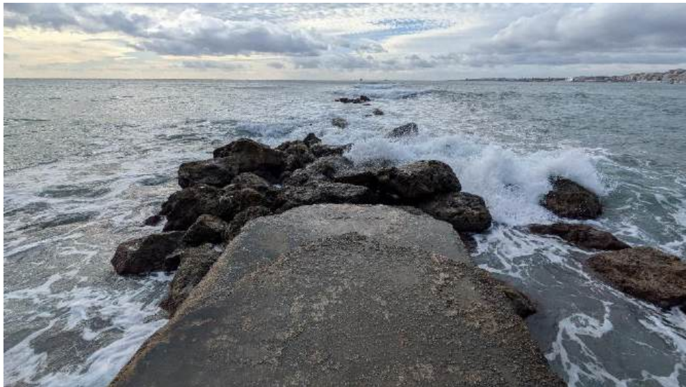
Ilustración 5: estado actual punta del espigón
