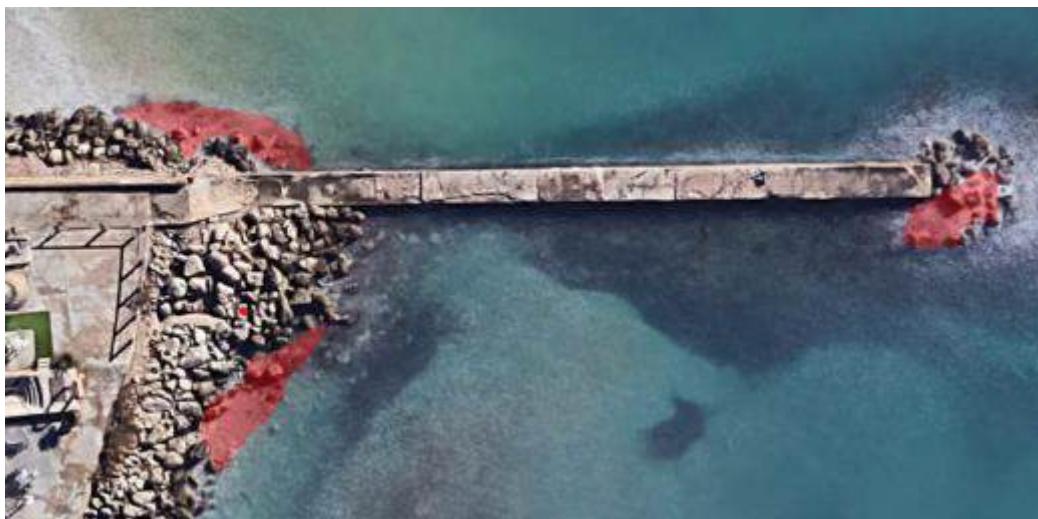
Ilustración 8: reposición de escollera
