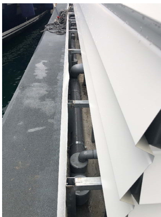
Imagen 9. Vista colector exterior
