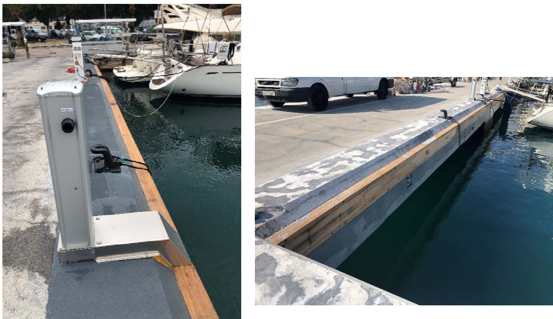
Imagen 12. Torretas de extracción y forrado de tuberías.
