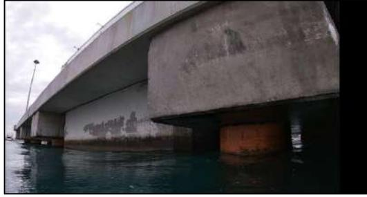
A continuación, tras la estructura de pilotes, nos encontramos con 6 vanos. En el lado interior, hacia el lado tierra en toda su longitud existe un muro corrido de hormigón que se encuentra en buen estado. Las pilas en toda la alineación también se encuentran en buen estado.
