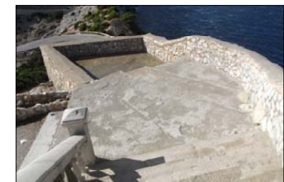
03. COLOCACIÓN DE BARANDILLA EN MIRADOR
