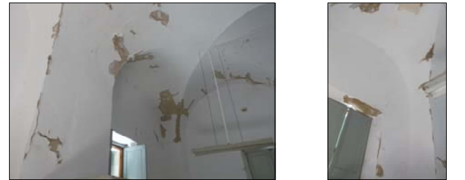
02. PINTADO Y SANEADO DE PAREDES INTERIOR EDIFICIO
