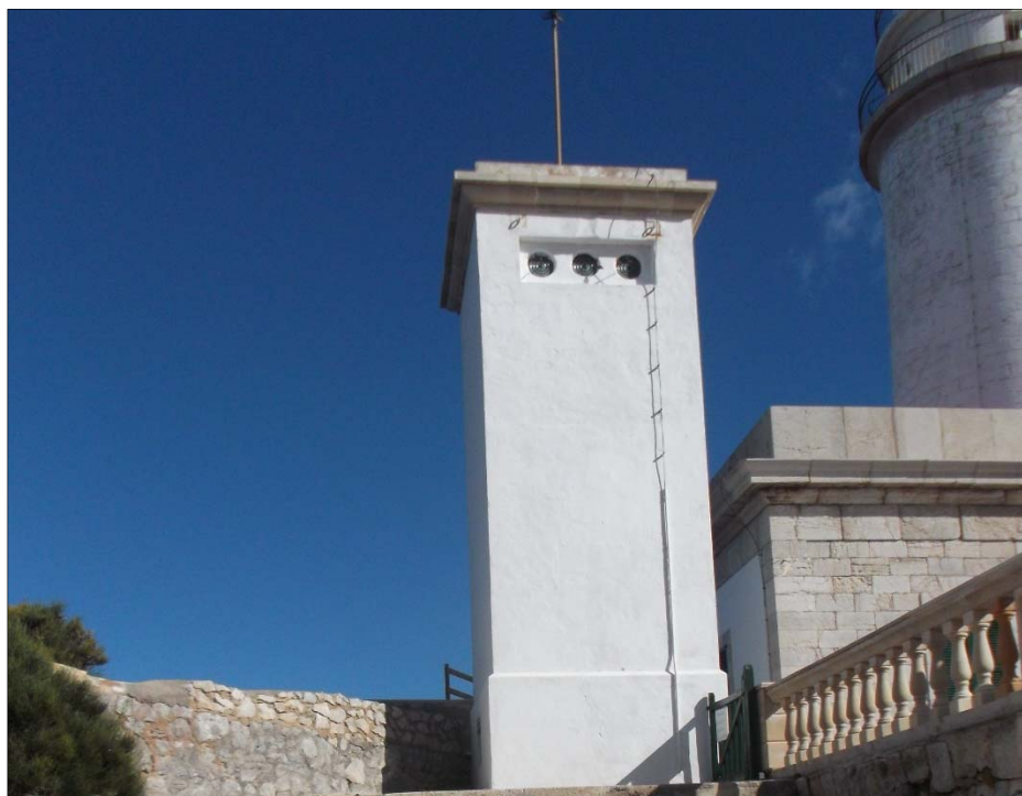
Imagen 7. Torre estación transformadora en desuso
