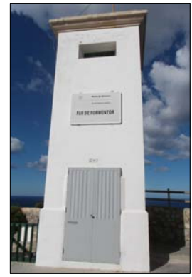
01. TRANSFORMADOR A DEMOLER
