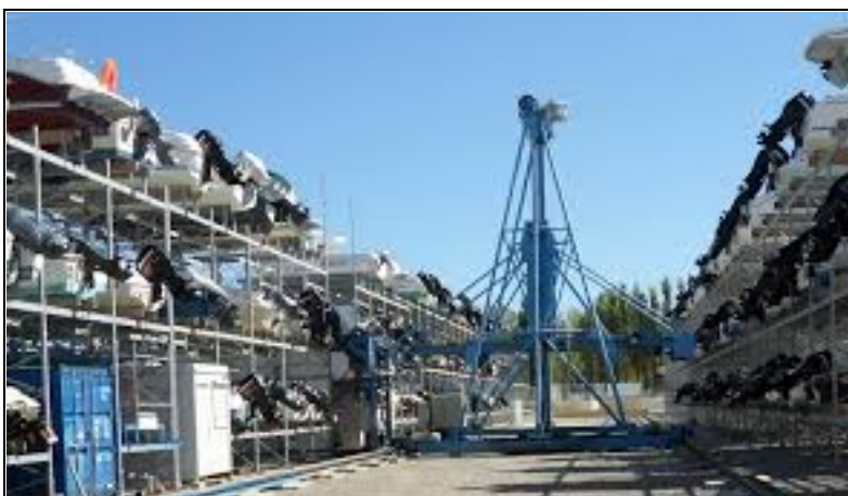
Figura 7. Ejemplo Marina Seca Automatizada
